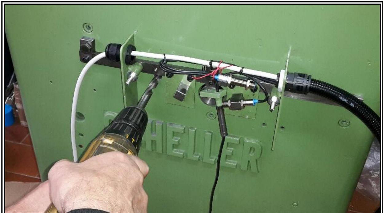
Fig.11.B.(Allargare il foro con la punta di 12mm)
