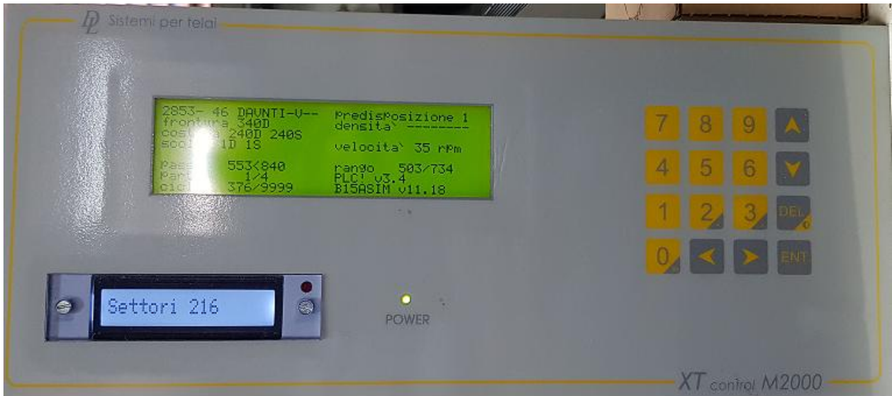
Fig.N.2 Installazione driver nel pannello
